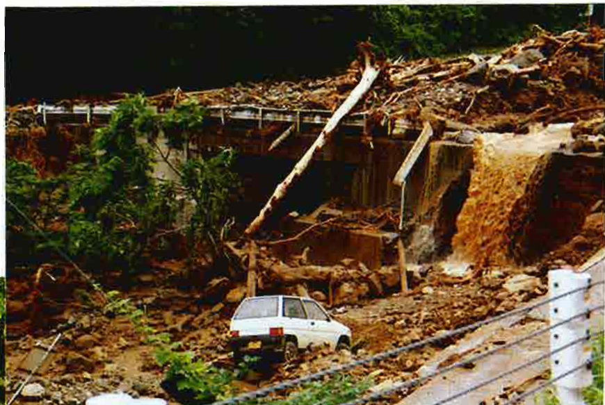
土石流で道路封鎖
