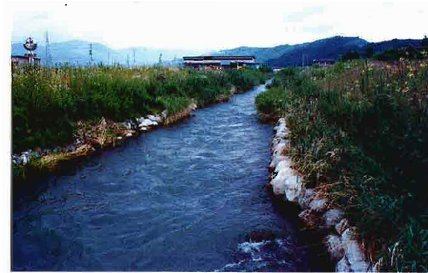
被害がなかった空石積
