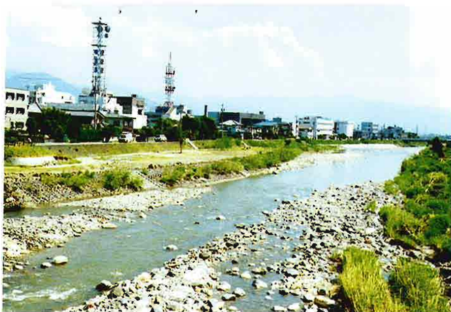
被害がなかった蛇カゴ護岸
