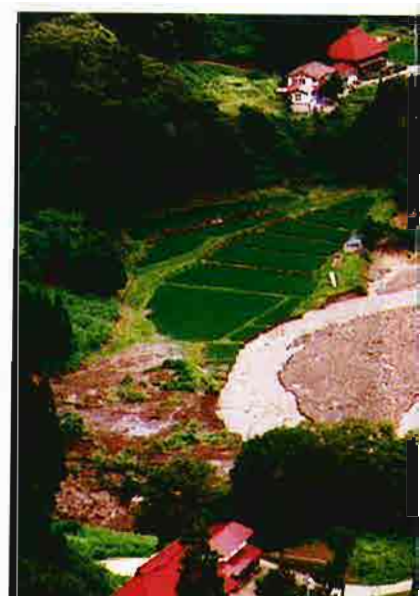
河道を埋め尽くした
