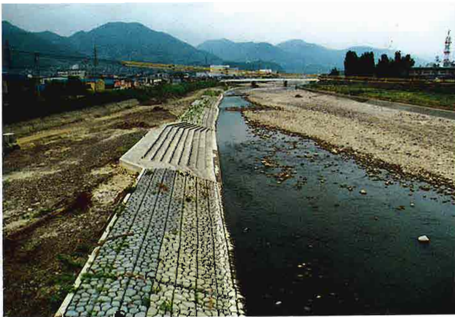
被害がなかったブロック護岸
