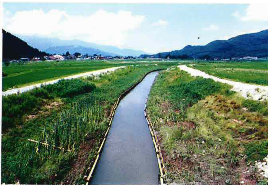
被害がなかった木柵工
