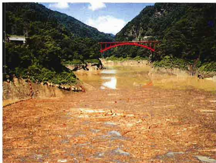
裾花ダムの流木(奥裾花ダムと裾花ダムで約2,000m 3 の流木の流出をふせぎました。)
