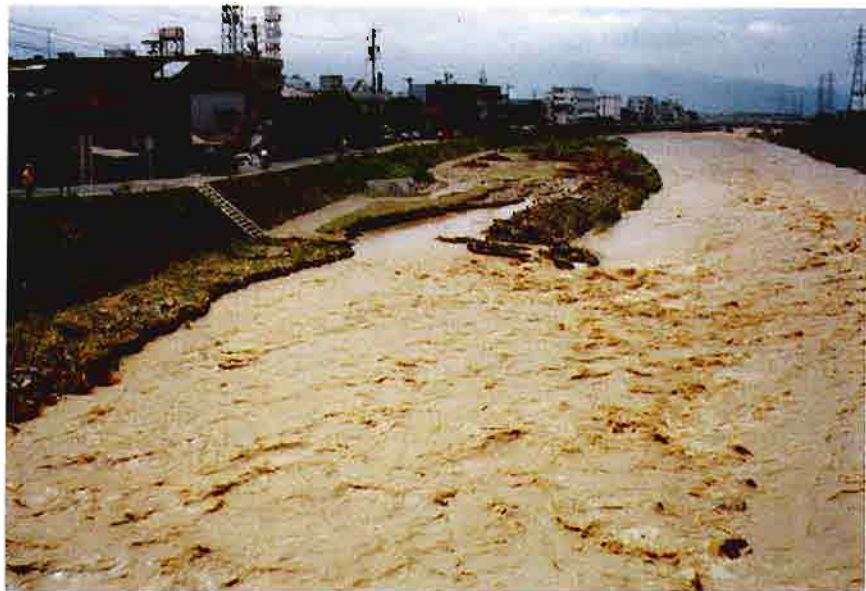
被災した高水敷（蛇カゴは上流端で崩壊）
