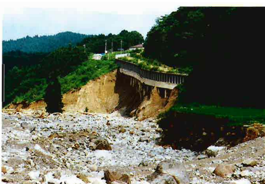
大きく削られた河岸（信濃町／関川）
