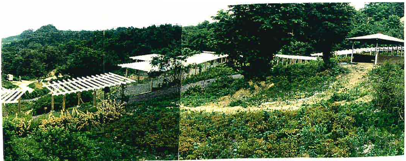
写真-83 植物園として整備された地すべり地上部、B～B測線上方。藤棚と四阿が望まれる。 1985年（昭和60年）撮影。
