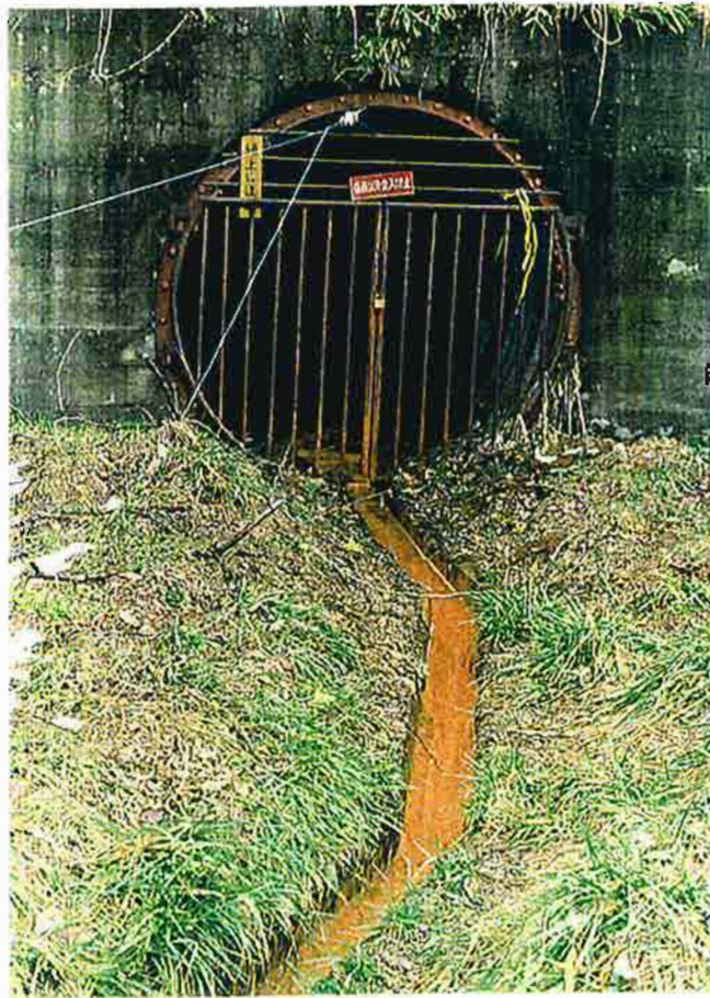
写真-71 1号トンネル坑口の状況。 1992年（平成4年）4月撮影。
