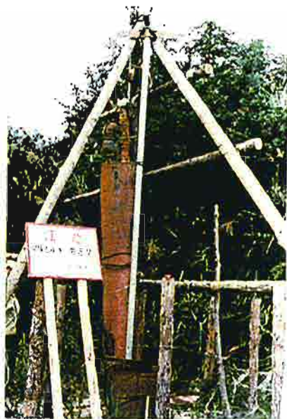
写真-64 深井戸内へ入れた加圧排水式ポンプ。 1967年（昭和42年）撮影。
