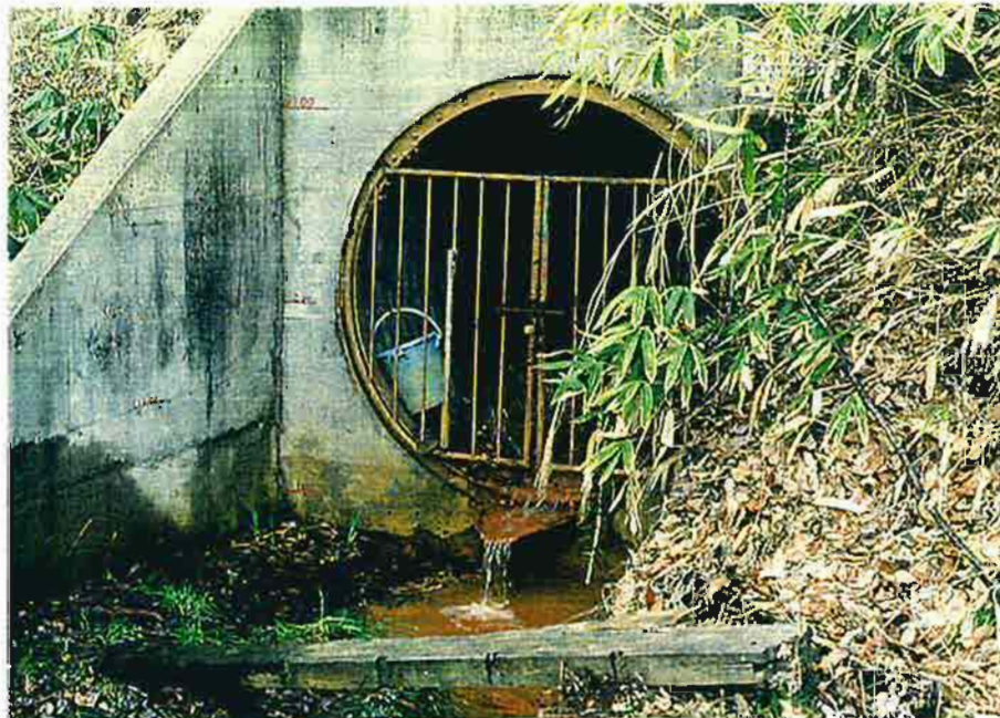
写真-72 2号トンネル坑口の状況。 1992年（平成4年）4月撮影。
