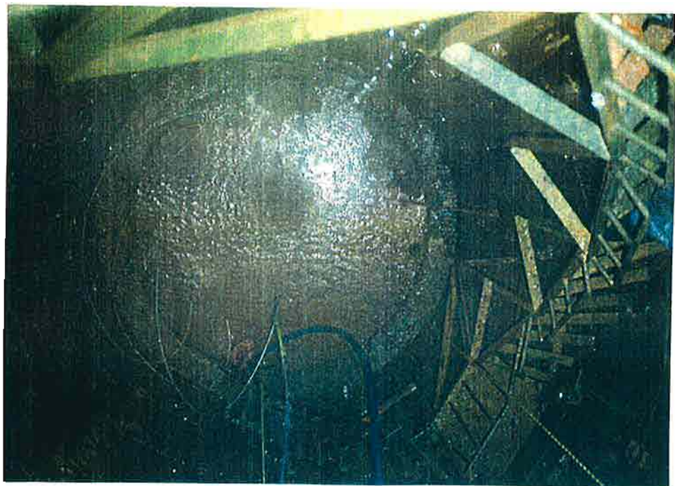
写真-79 RCセグメント集水井の内部の状況。 1992年（平成4年）7月撮影。
