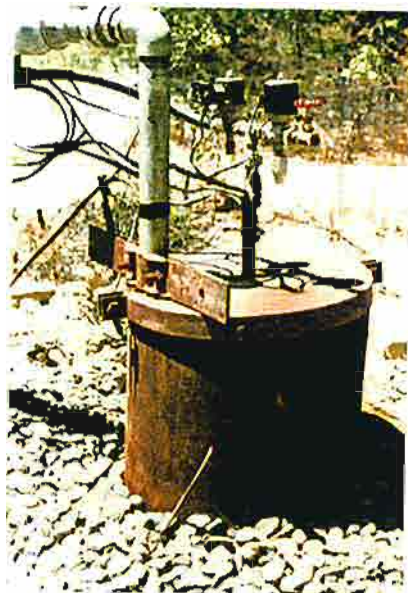
写真-65 深井戸工の頭部の状況。 加圧排水式ポンプから出ている排水管と 圧縮空気の出入を調整する装置が見える。 1967年（昭和42年）撮影。
