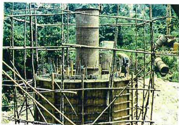
写真-66 1号集水井筒（ケーソン工） 施工中の状況。 1969年（昭和44年）撮影。
