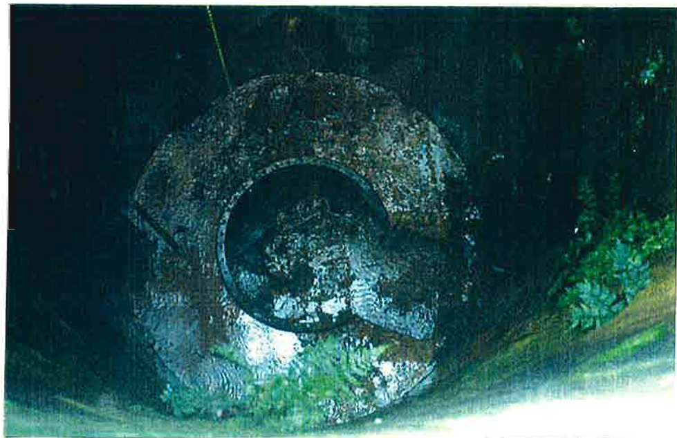
写真-80 4号ケーソン工内部の状況。 1992年（平成4年）7月撮影。
