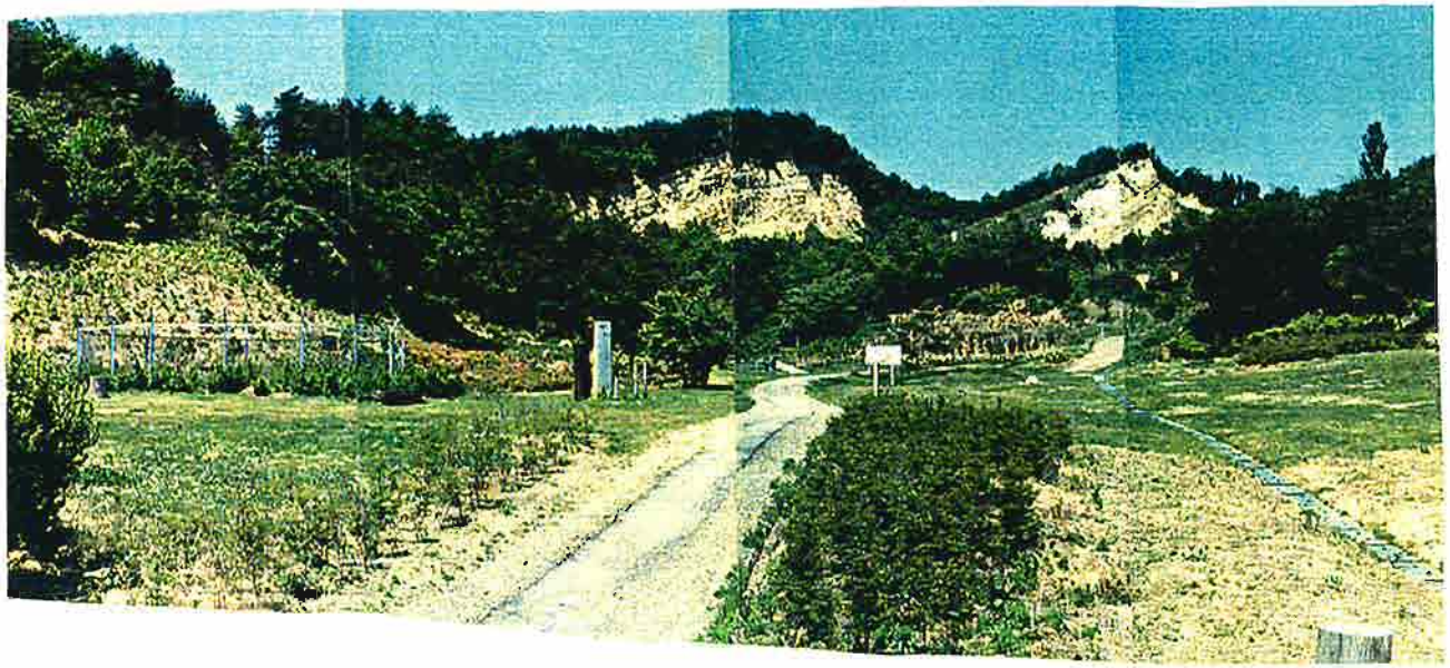
写真-81 植物園として整備された地すべり地上部。左側の金網柵は2号集水井筒（ケーソン工）。 1985年（昭和62年）6月撮影。
