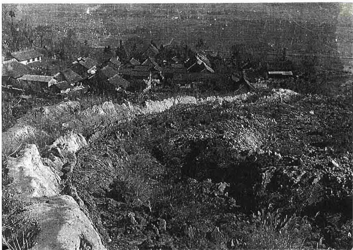
写真-58 山新田集落の上方から側面へ押しつける地すべり土塊の状況。 1948年（昭和23年）撮影。
