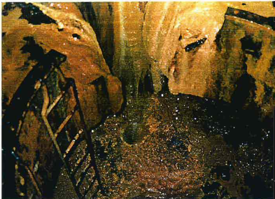
写真-76 4号ケーソン 工底の状況。 1992年(平成4 年)7月撮影。
