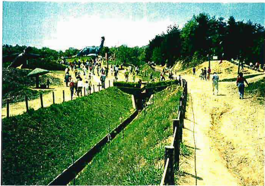
写真-84 恐竜公園の にぎわいと整 備された水路 工。1985年(昭 和60年)5月撮 影。
