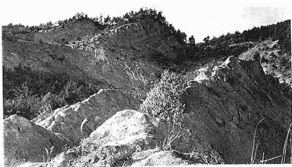
写真-41 地すべり地上部の状況。 1949年（昭和24年）5月撮影。
