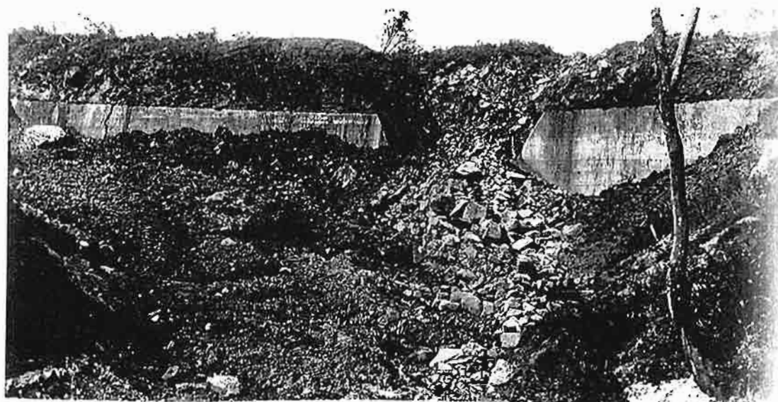
写真-32 寺内堰堤を土砂が乗り越えている状況。1936年(昭和11年)7月撮影。
