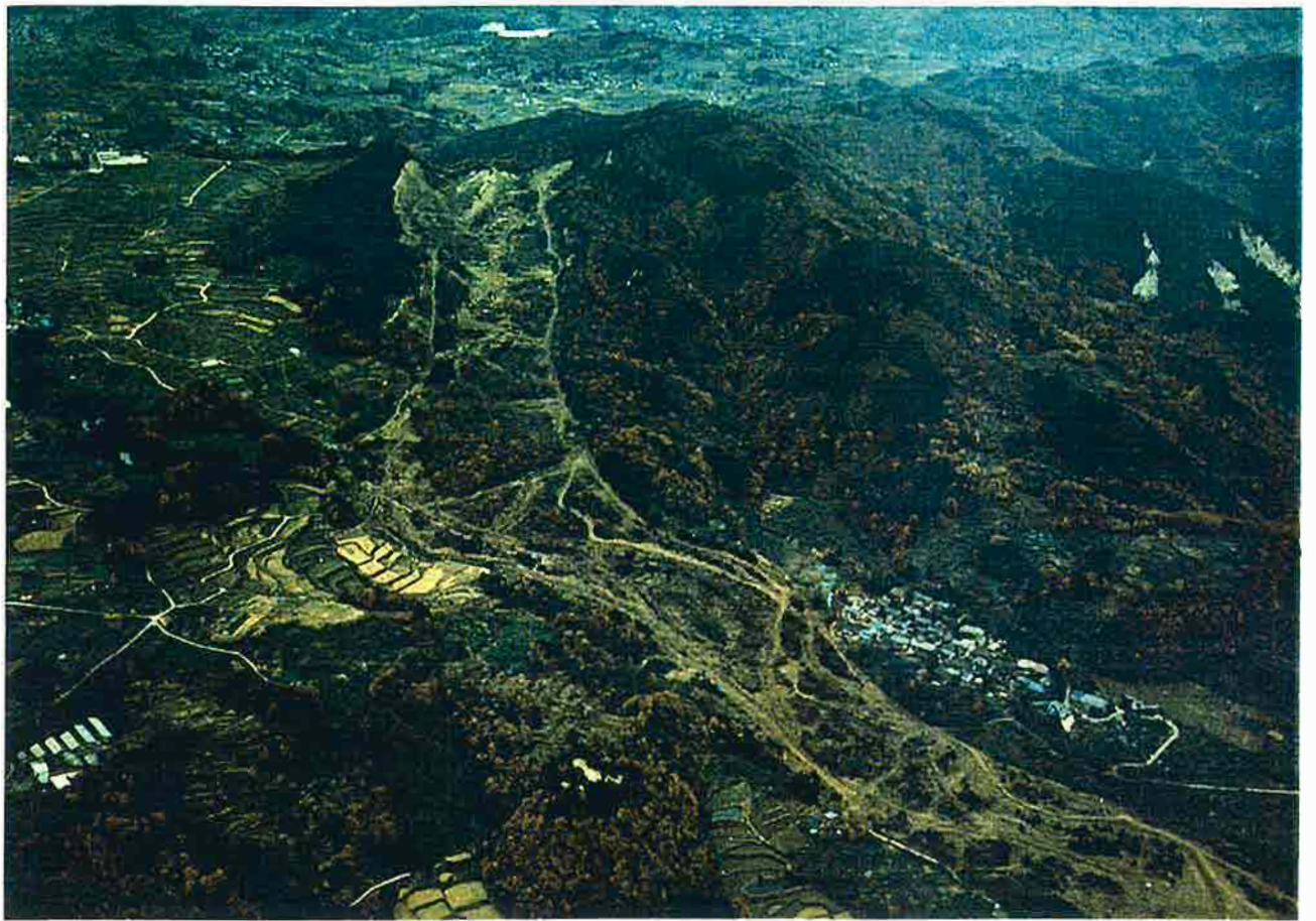
写真-2 地すべり地中部～上部の状況。1976年（昭和51年）11月撮影。
