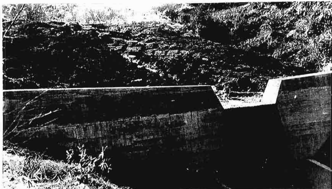
写真-30 滝沢川下流部に施工した寺内堰堤竣工時の状況。1936年(昭和11年)3月撮影。
