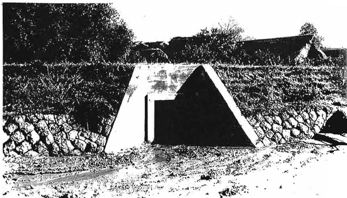
写真-28 宇土沢川付 け替え工事、 山新田集落上 部の暗渠取入 口。1935年(昭 和10年)10月 撮影。
