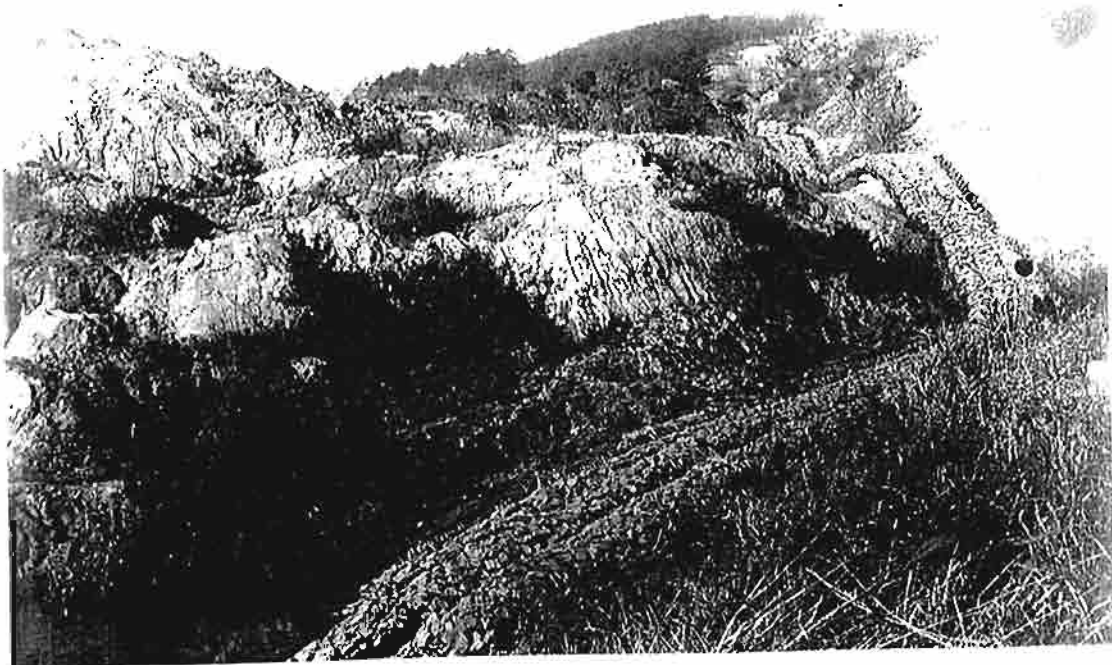
写真-23 昭和7年度 施工の蛇籠水 路工の変形状 況。1933年(昭 和8年)12月 撮影。
