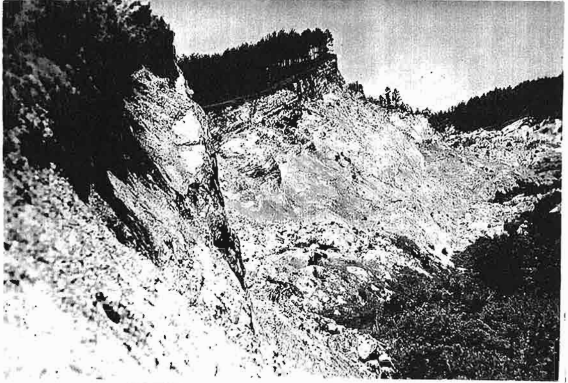
写真-17 地すべり地最上部の状況。 右岸側滑落崖。1933年（昭和8年）5月撮影。
