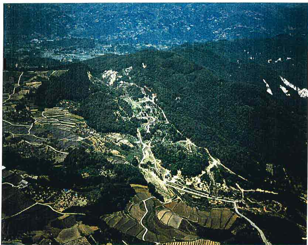
写真-5 地すべり地上部の状況。1982年（昭和57年）10月撮影。
