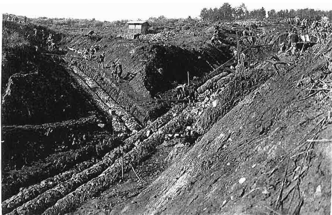
写真-19 蛇籠水路施工中の状況。 1933年（昭和8年）5月撮影。
