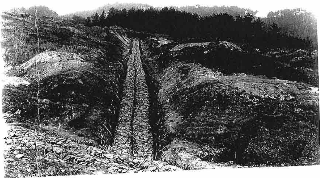
写真-22 蛇籠埋設状 況。第3支線 延長50m。1933 年(昭和8年)8 月撮影。
