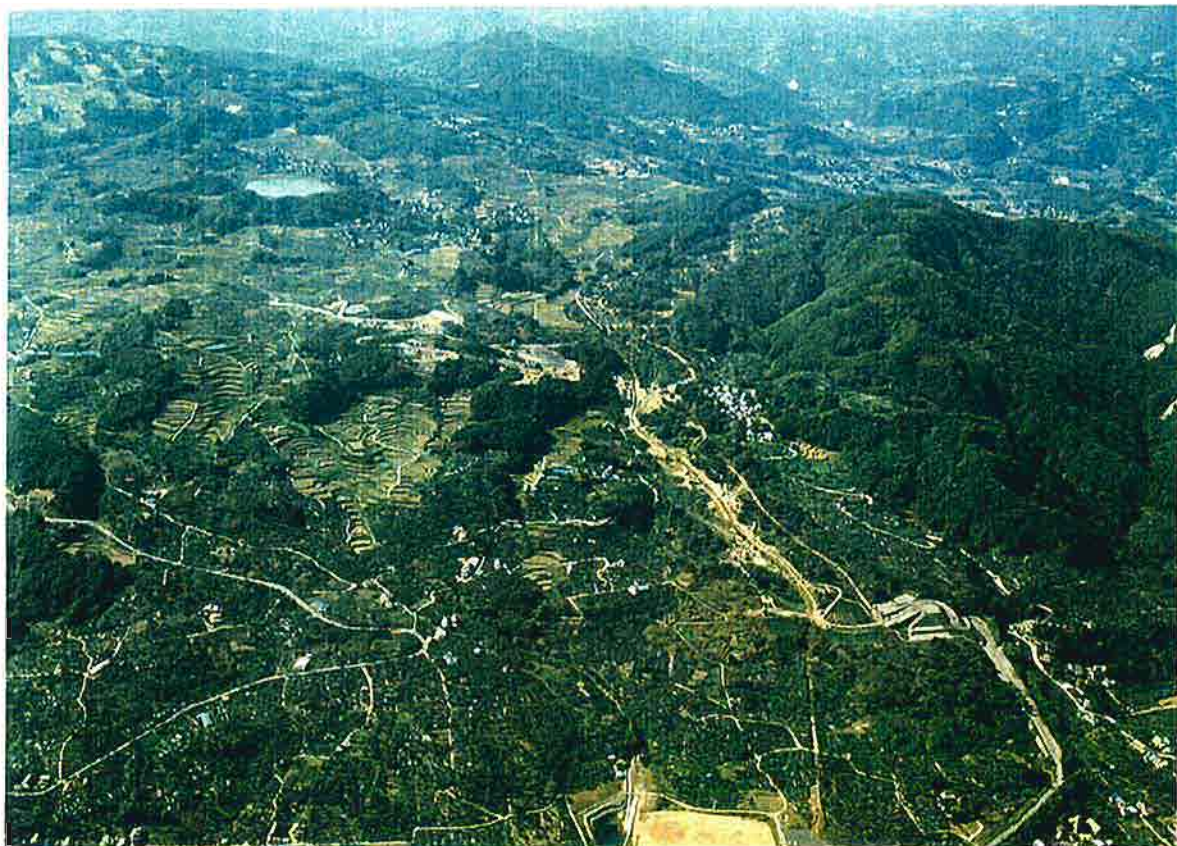
写真-4 地すべり地全景。1982年（昭和57年）10月撮影。
