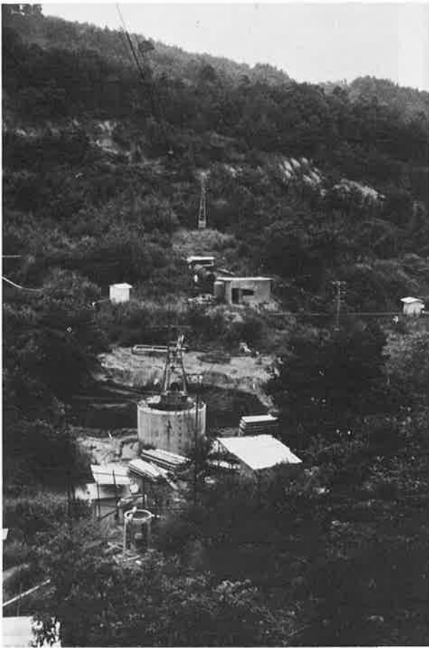
写真-5 ↑ 地すべり地上部（上沼）における 1号ケーソン工施工中の状況 昭和44年（1969）8月撮影
