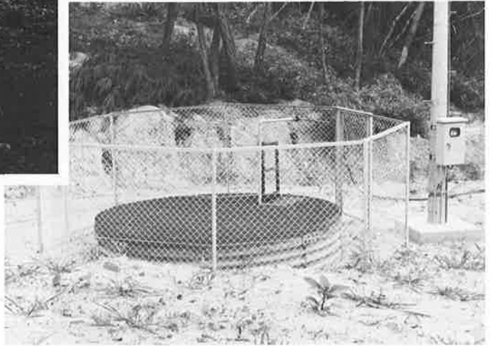
写真-6 ↓ 不動島上方に施工した ライナープレート集水井 昭和55年度施工
