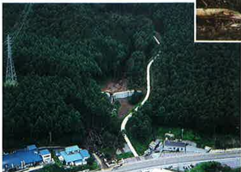
土石流や流木約2,000m 3 を捕捉、人家25戸、国道20号、病院や老人ホームなどを保全した(岡谷市間下 ヒライシ沢砂防えん堤)
