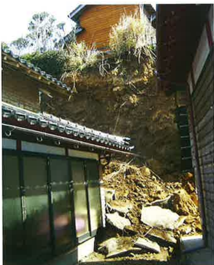
③急傾斜地の崩壊（志賀町・赤崎地区）
