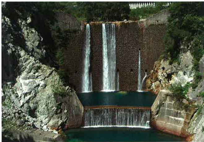
釜ヶ淵砂防えん堤 (昭和19年竣工、平成14年9月有形文化財に登録)
