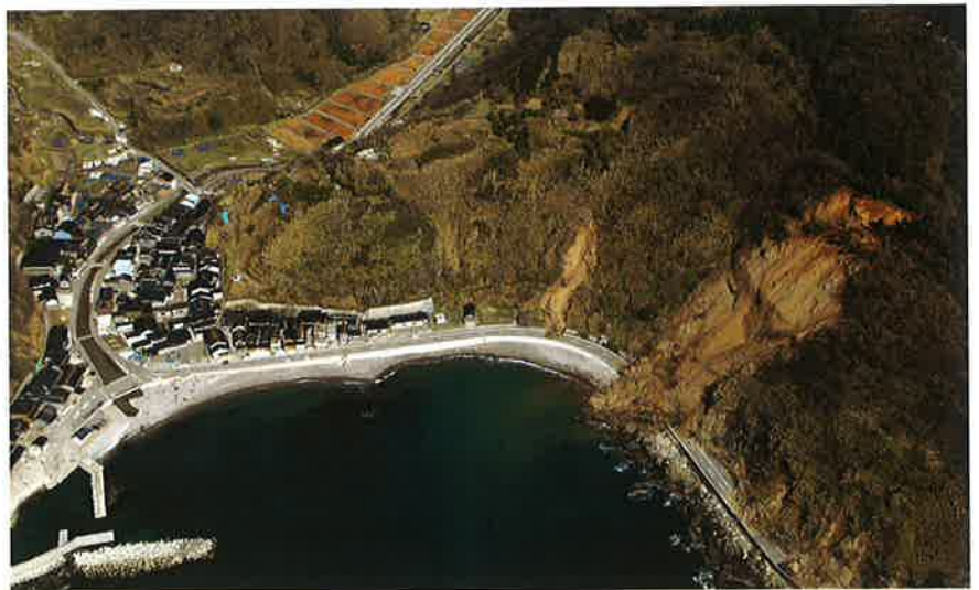
②市道・道下深見線の被災（輪島市）
