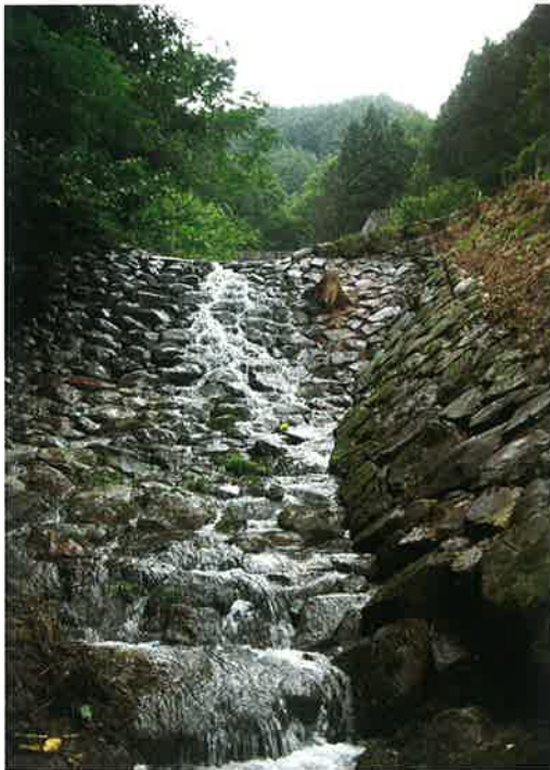
荏沢川第1号砂防えん堤 (明治15~18年・千曲市)
