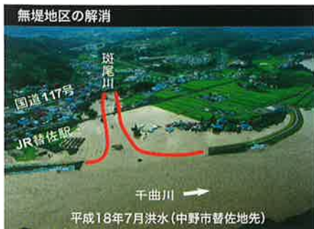
無堤地区の浸水を防ぐために新たに堤防をつくります。
