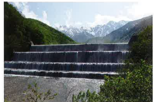
平川源太郎砂防えん堤
