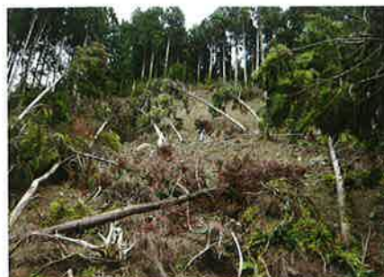
④斜面崩壊の発生（輪島市門前中野屋）
