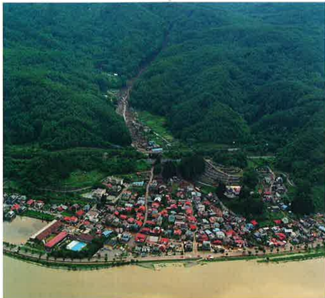
7名の方が犠牲となった小田井沢川土石流被災地 (岡谷市湊三丁目 小田井沢川)
