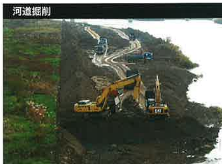
河道の掘削を行い、流下能力の向上を図ります。
