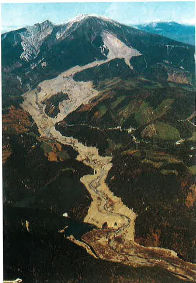
御岳山とその山体崩壊から流下した土石流
