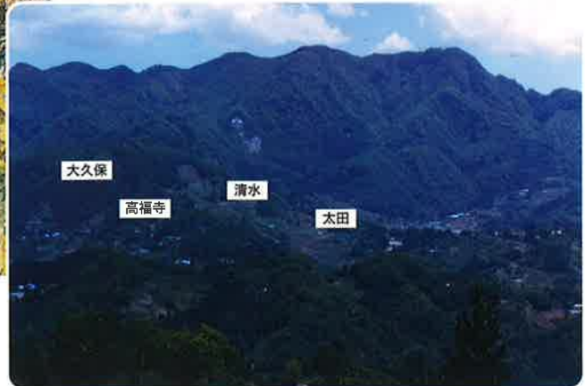
虫倉山系崩壊地現況写真 (南側から望む)
