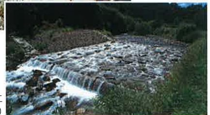
全幅斜路の床固工 (野表沢流路工)
