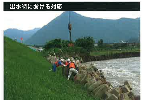
ブロック投入するなど緊急復旧対応により被害の軽減を図ります。
