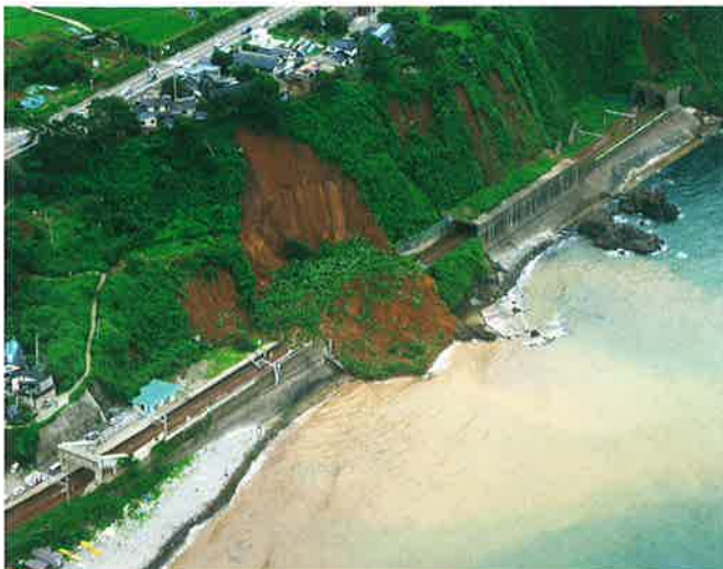
①地すべり(柏崎市青海川地区)
