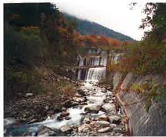
笹川第1号砂防えん堤
