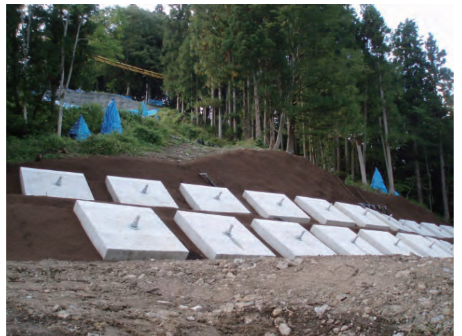
対策工：アンカー工
