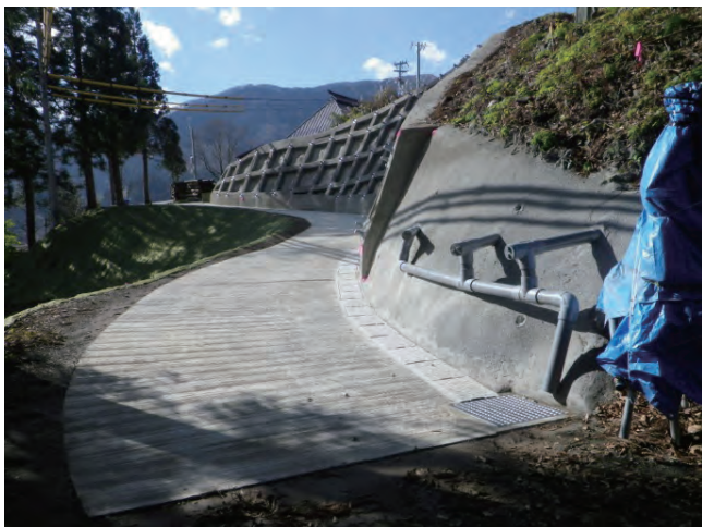
対策工：横ボーリング工、法砕工
