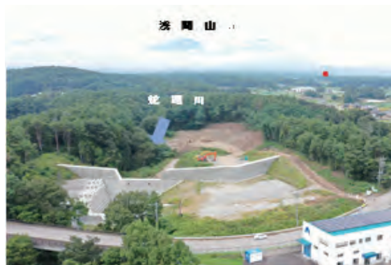
蛇堀川砂防堰堤（小諸市）
