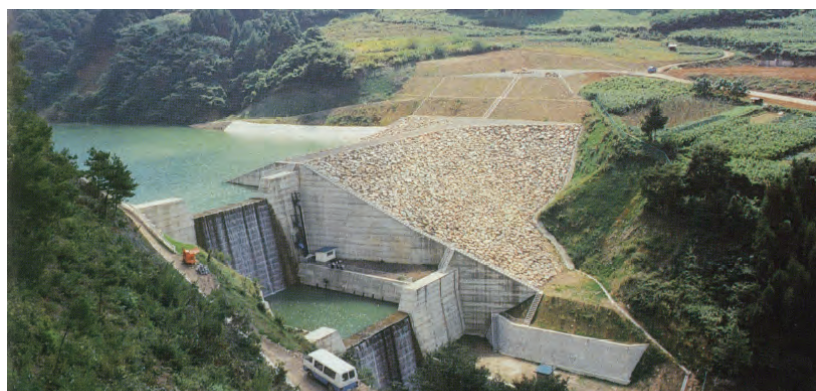
(砂) 月沢 松本市 月沢砂防堰堤
