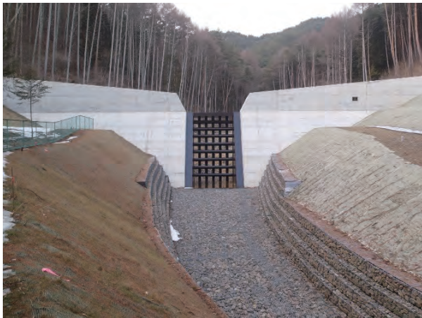
ワイヤネット式 砂防堰堤
