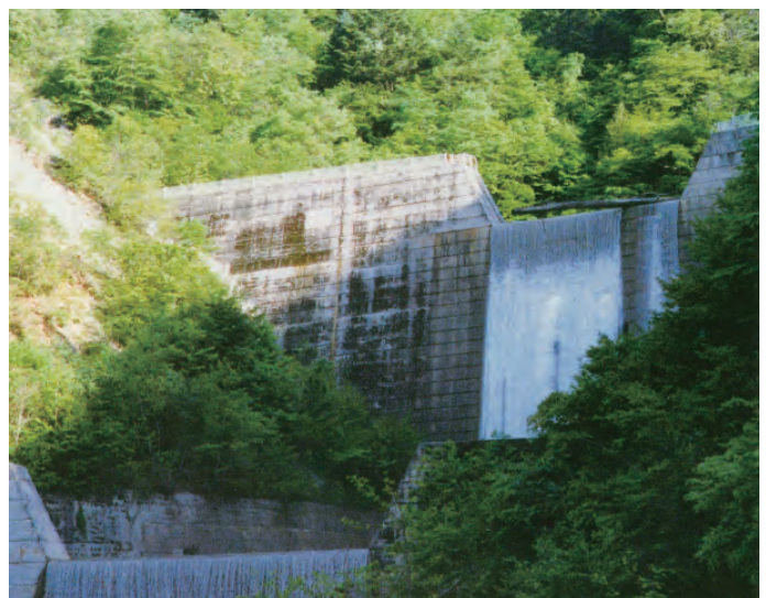
(砂) 上山沢 南木曾町 与川砂防堰堤
