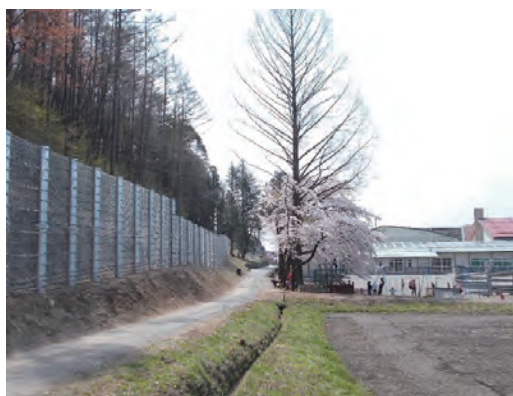
要配慮者利用施設（小学校）を守るがけ崩れ対策
