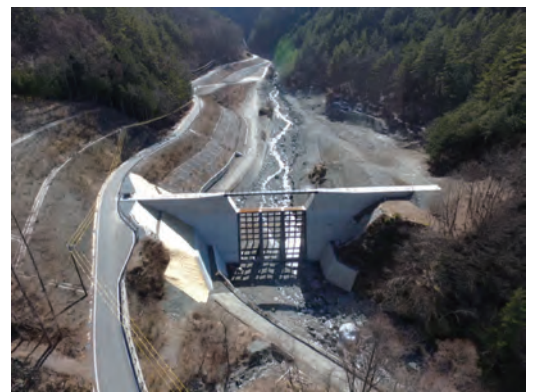
塩川 塩川第2砂防えん堤(大鹿村)
