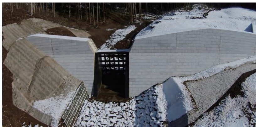
(砂) 三ノ沢 木島平村 原大沢2号砂防堰堤
