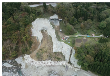
施工中の屋敷地区法面对策工
