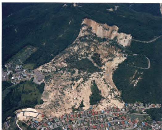
長野市 地附山地すべり 被災状況
