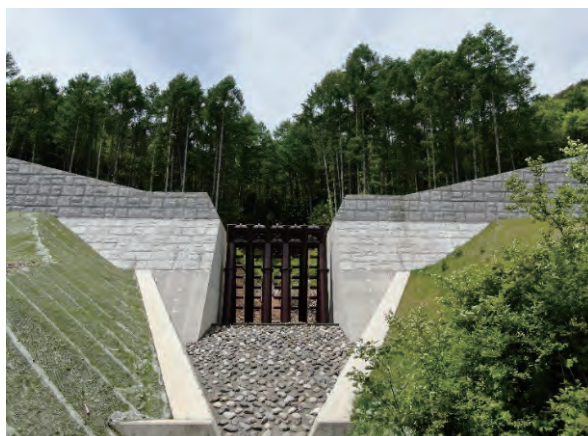
砂防堰堤と取付水路工を整備
