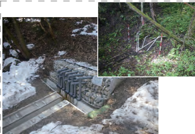
【横ボーリング工の改築】
