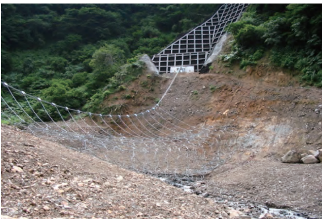
ワイヤネット式 砂防堰堤
