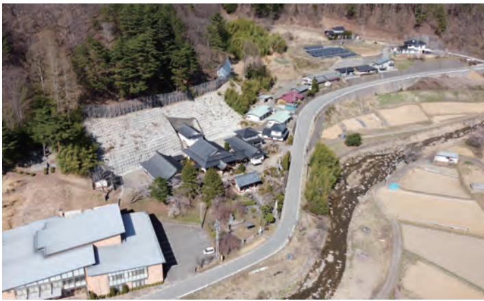
集落を守る法枠工、崩壊土砂防止柵工 (南相木村、上土岩)
