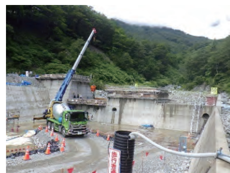
施工中の猿倉砂防堰堤
