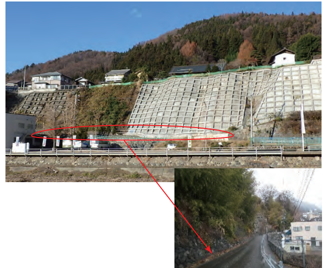
集落及び避難路を守る法枠工 (山ノ内町 安代)
