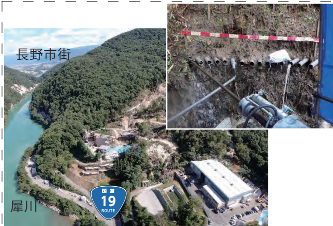
【横ボーリング工の施工状況】
