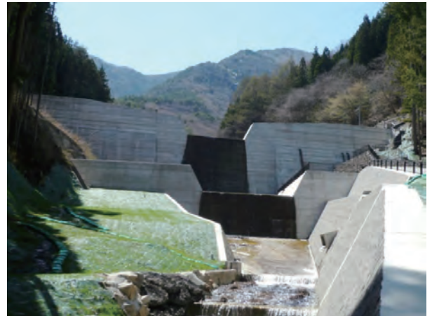
(砂) 白川 青木村 白川砂防堰堤
