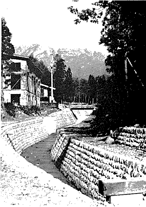
大橋川流路工 (姫川支大橋川……北安曇郡白馬村)
