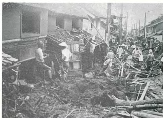
湯福川の氾濫 昭和12年7月28～29日、長野市周辺を襲った集中豪雨による長野市横沢町の惨状
