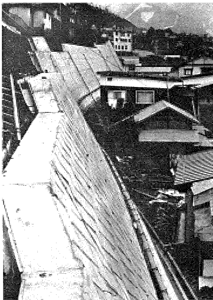
山ノ内町星川の急傾斜地崩壊対策工事
