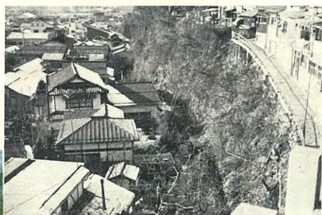
中房川流路工 (犀川支 穂高川小支 中房川、南安曇郡穂高町) 延長約1,300.0m 法高3.35m～5.03m 施行年度 S. 35～39年度 本川は北アルプス燕岳、大天井岳に源を発し、流出土砂により 発達した扇状地砂礫層の上を乱流しているため、縦横浸蝕はな はだしく下流に甚大な被害をおよぼしているため、本計画によ り流路整正をはかった。
