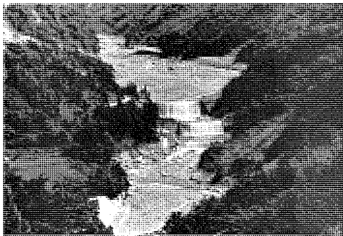
天竜川支小渋川の 釜沢砂防ダム(直轄S12~16年度) (H=10m L=53m 貯砂量 59.080m 3 )
