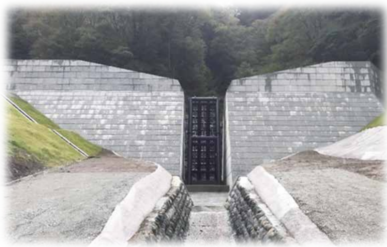
完成した滝の沢砂防堰堤
