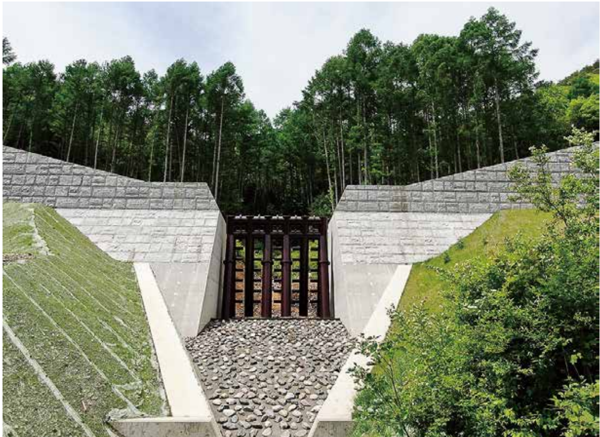
杣沢砂防堰堤(木祖村)
