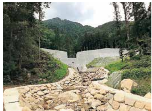
岩戸沢砂防堰堤
