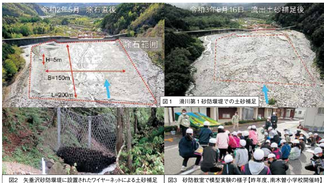
図2 矢垂沢砂防堰堤に設置されたワイヤーネットによる土砂補足
