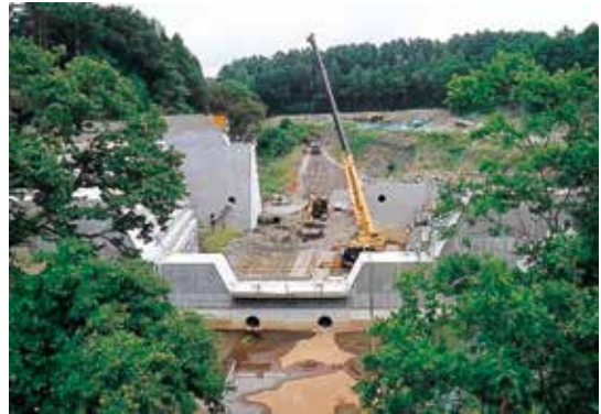
施工中の蛇堀川堰堤（小諸市）（令和元年9月）
