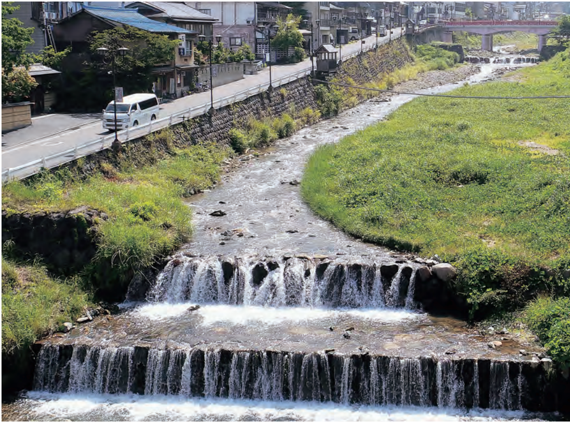
第39号石堰堤 (山ノ内町夜間瀬川 大正13年竣工) [「歴史から学ぶ 地域防災」夜間瀬川直轄砂防施工100周年記念シンポジウム開催 日時：平成30年11月8日 (木) 13:30～ 会場：山ノ内町文化センター3階ホール]
