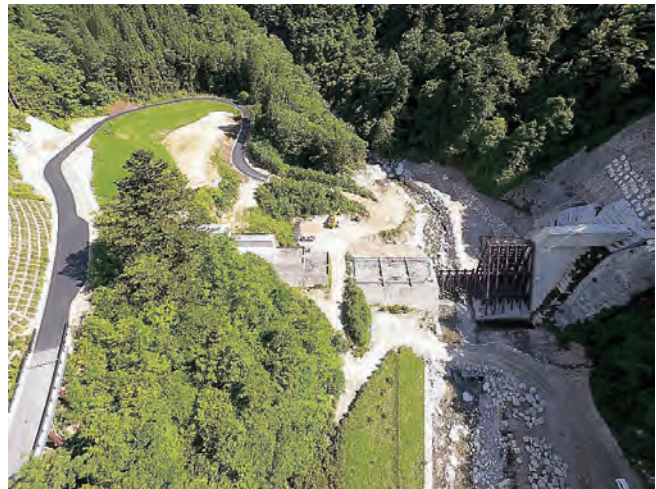
建設中の越百第3砂防堰堤
