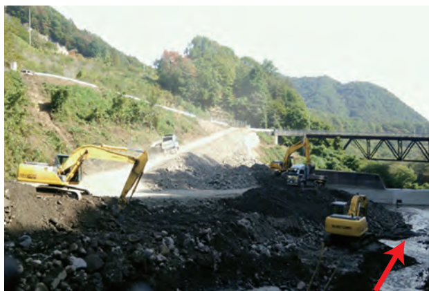
写真-1 木曾町（砂）湯川における 倉本砂防堰堤の除石工事状況
