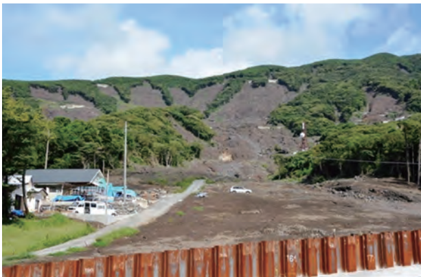
神達地区で視察した広範囲な山腹斜面崩落部
