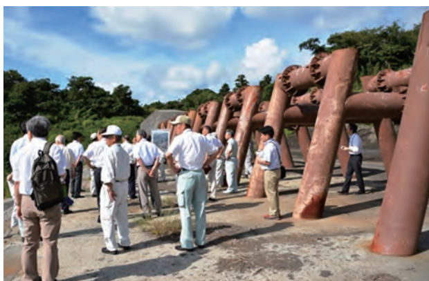
多量の流木を食い止めた大金沢堆積工のスリット堰堤
