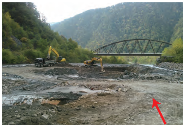
写真-2 王滝村（砂）濁沢川における 濁沢第一砂防堰堤の除石工事状況
