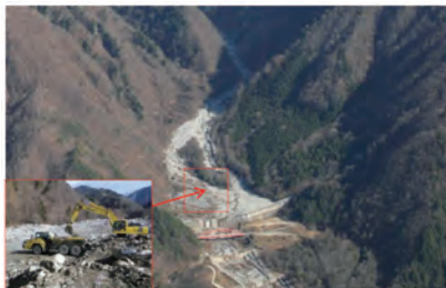
緊急除石の対応 (滑川第1砂防堰堤、H24)
