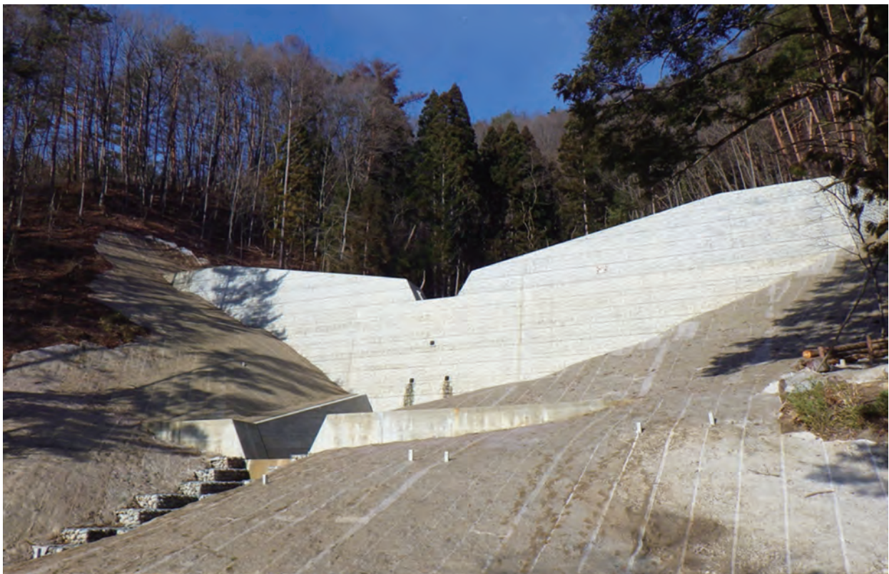
日岐沢砂防堰堤 東筑摩郡 生坂村 H26年2月完成 H=12.5m L=68.0m C=195百万円 (H22~H25)
