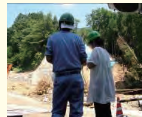
ラジオ局による砂防工事現場レポート
