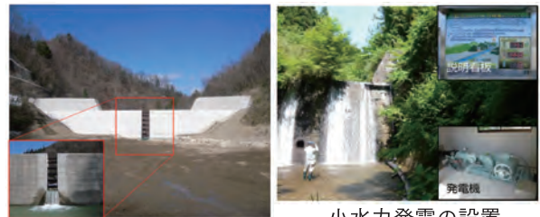
既設砂防堰堤へのシャッター設置 (上山沢第1砂防堰堤、H25) 小水力発電の設置 (梨子沢砂防堰堤、H25)
