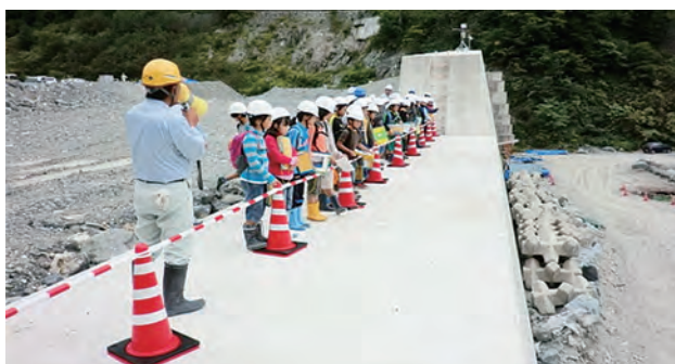
現場代理人からの工事説明(南股上流)
