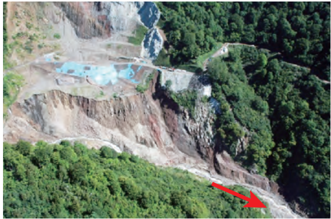
写真-4 中条川 栄村 中条（上流部崩壊状況）
