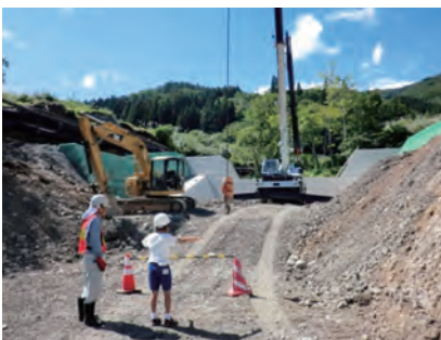
クレーンへの作業合図体験(虫尾)
