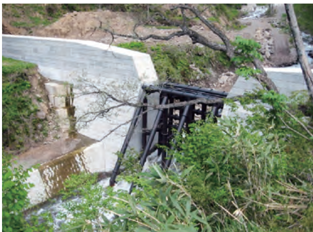
写真-6 砂防堰堤(格子型) 捕捉前 平成25年2月完成
