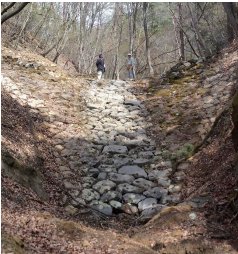
麻績村新沢に現存する石積み堰堤 (明治20年頃国直轄施工)
