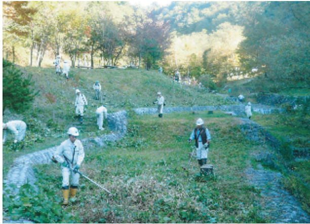
重要文化財「牛伏川階段工」周辺の維持管理活動
