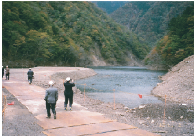
No.5 五條市大塔町宇井地区深層崩壊で 河川閉塞で出来た自然ダム
