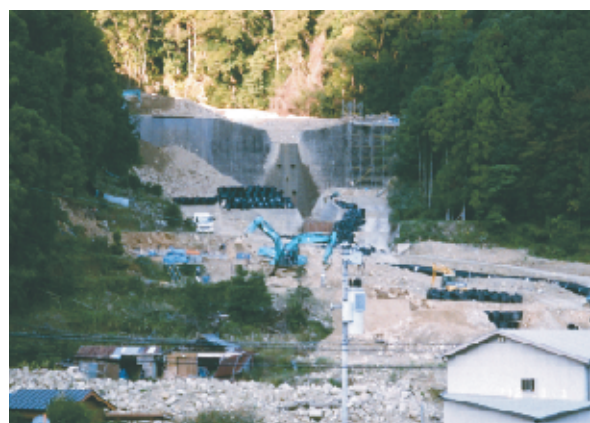
No.1 内の川の県設置砂防えん堤
