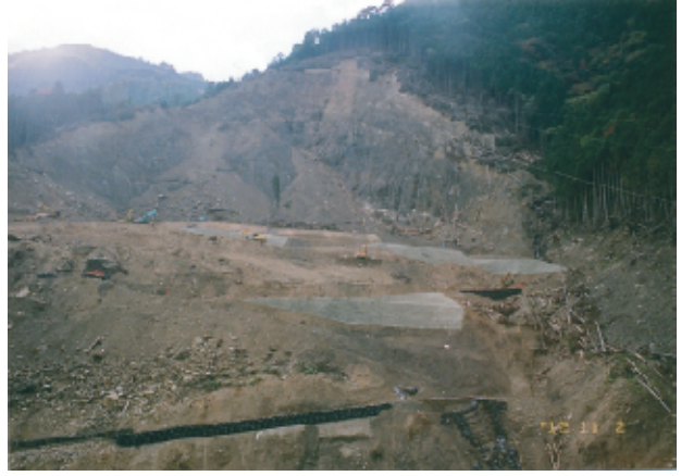
No.3 五條市大塔町宇井地区深層崩壊現場
