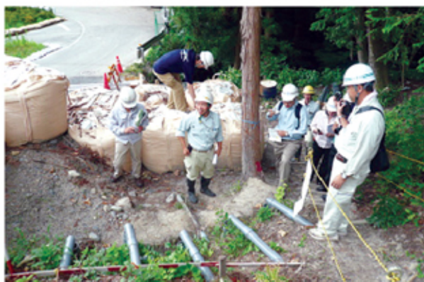
(写真2) 対策実施中の現場視察
