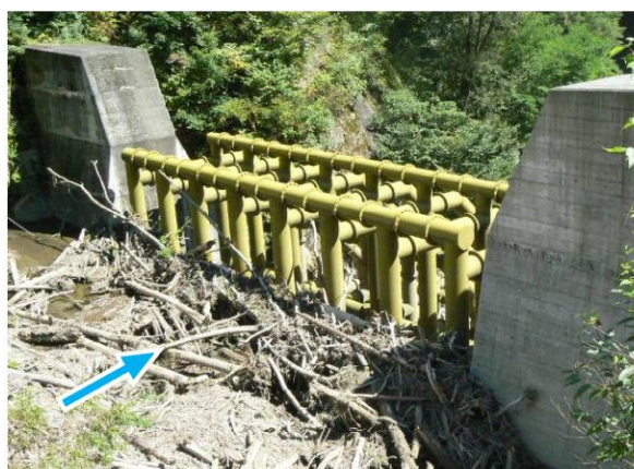
図-8 土砂及び流木捕捉状況 (楠川)
