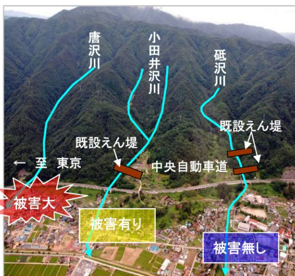
図-2 既設砂防えん堤位置と被害状況
