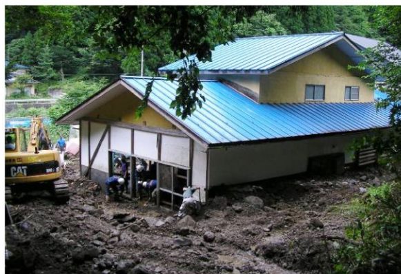
図-7 小楠川の被災状況
