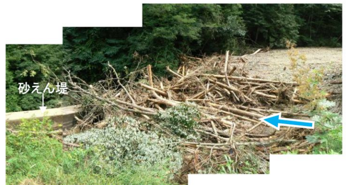
図-4 土砂及び流木捕捉状況 (小田井沢川)
