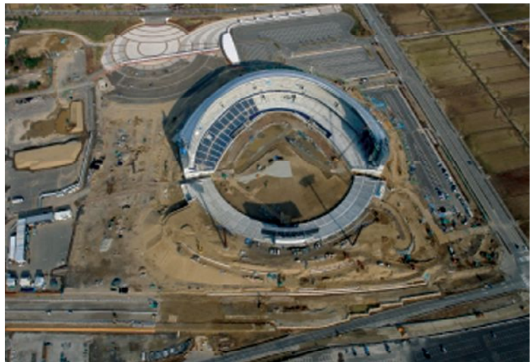
県立野球場の建設状況（21年2月）
