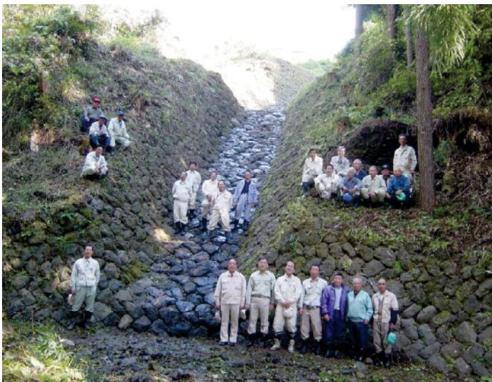
薬師沢（小川村稲丘）富吉沢石張水路工
