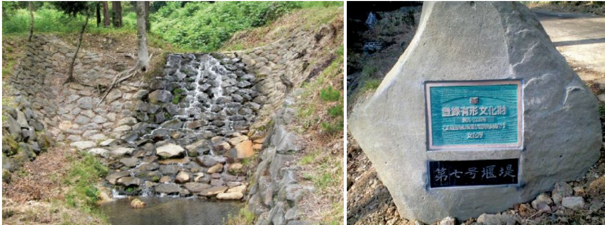
荏沢川7号石堰堤と、現地に設置された登録有形文化財プレート
