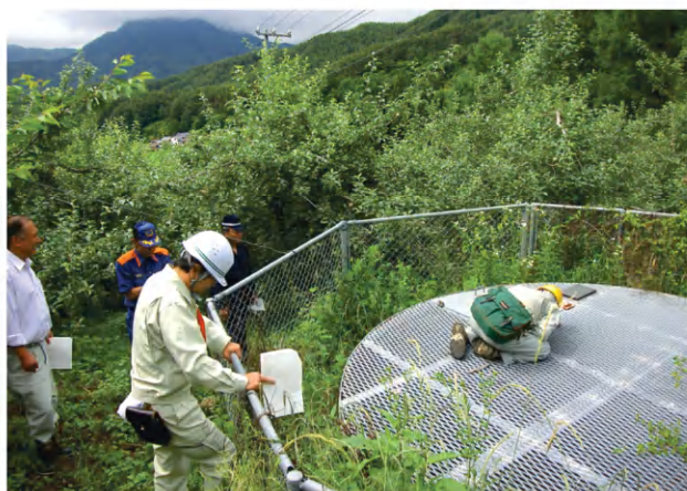
土砂災害防止月間に伴うパトロール 地すべり防止施設の点検(上田建設事務所)
