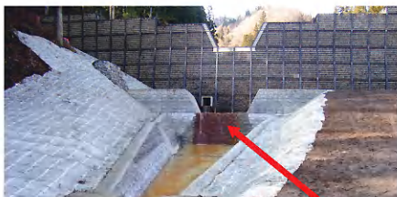
完成したえん堤
