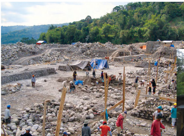
工事中の砂防えん堤（左奥にあるのが売店）
