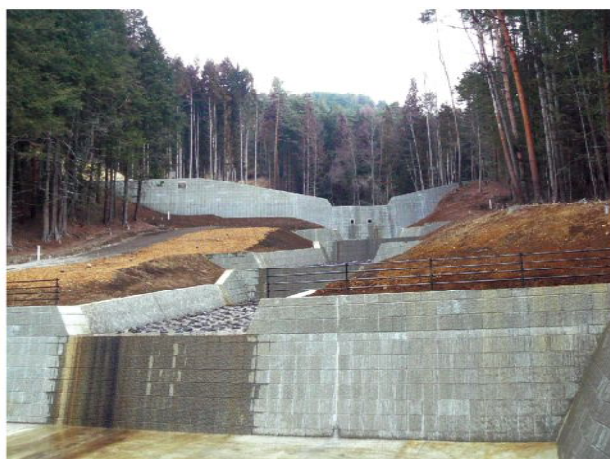
完成した施設の状況
