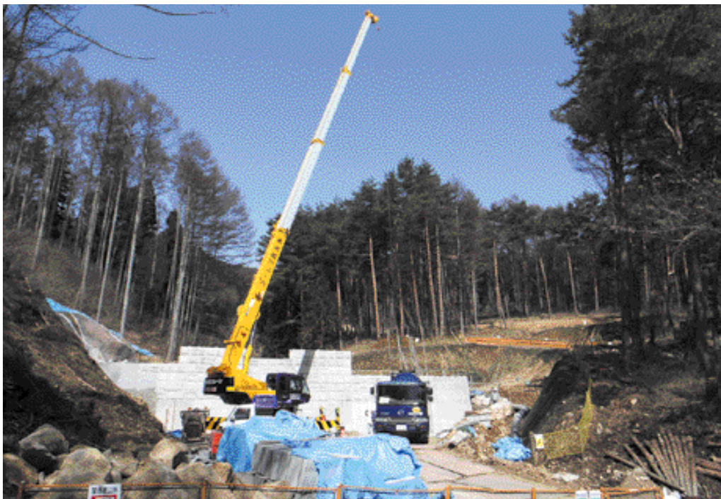
災害関連緊急砂防事業により、対策が進む 岡谷市待張川
