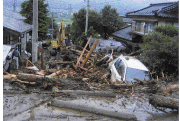
北小河内中村地区 土石流被害状況
