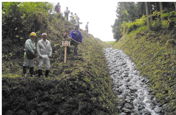
田畑会長による石堰堤看板の杭打ち式の様子
