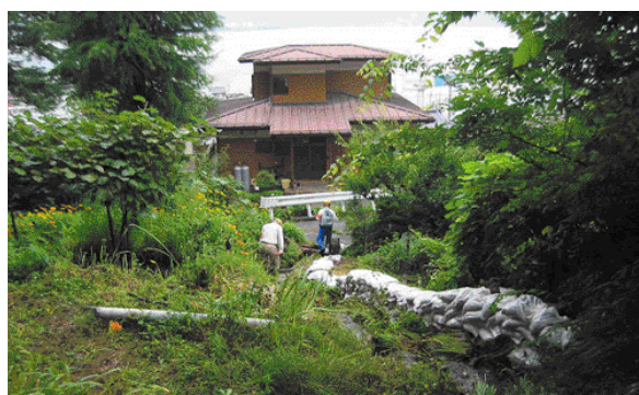
7月豪雨災害での土石流危険渓流調査の様子
