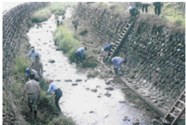
河床草刈、河川清掃状況
