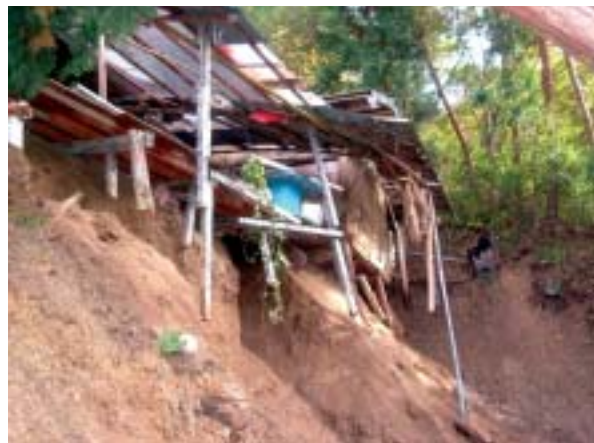
明科町庄部 地すべりにより人家が倒壊
