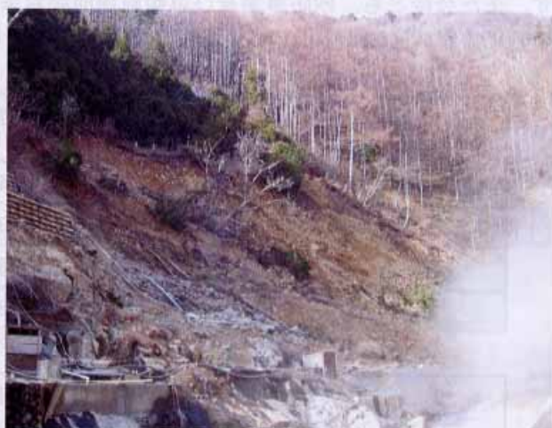
被災ブロック下部全景
