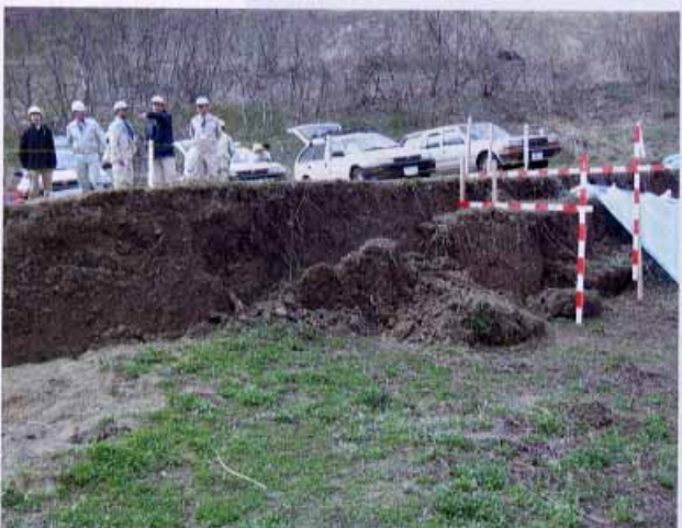
被災ブロック上部滑落崖
