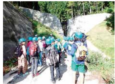
写真2 立の間砂防堰堤
