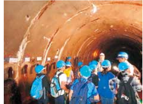
写真1 倉下排水トンネル
