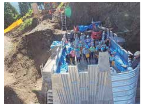
写真3 ガン沢砂防堰堤工事現場
