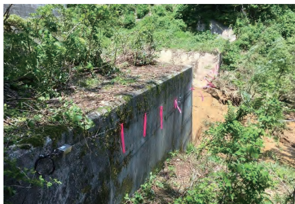
土石流センサー設置状況
