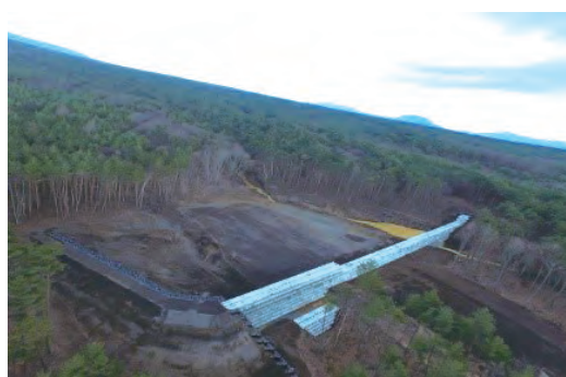
濁川(暫定緊急対策施設)
