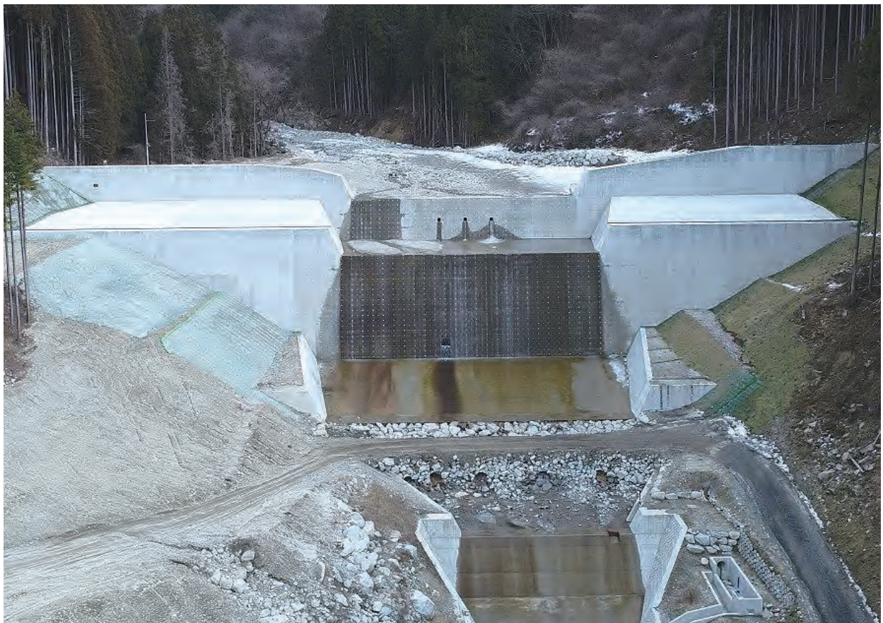
梨子沢砂防堰堤(南木曾町)
