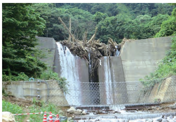
リングネット設置状況
