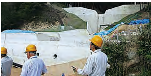
安佐北区可部6丁目の砂防事業(えん堤+遊砂池)と下流の状況
