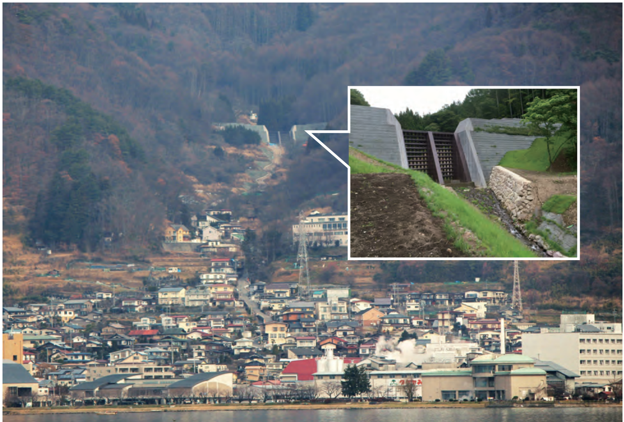
(砂)千本木川 オノ 大和 オノ 第3砂防堰堤 (諏訪市)
