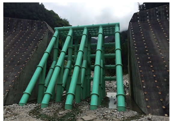
梨子沢第1砂防堰堤災害復旧工事 H27.10. 鋼製堰堤完成
