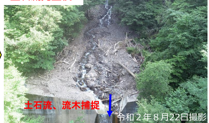
土石流発生後
