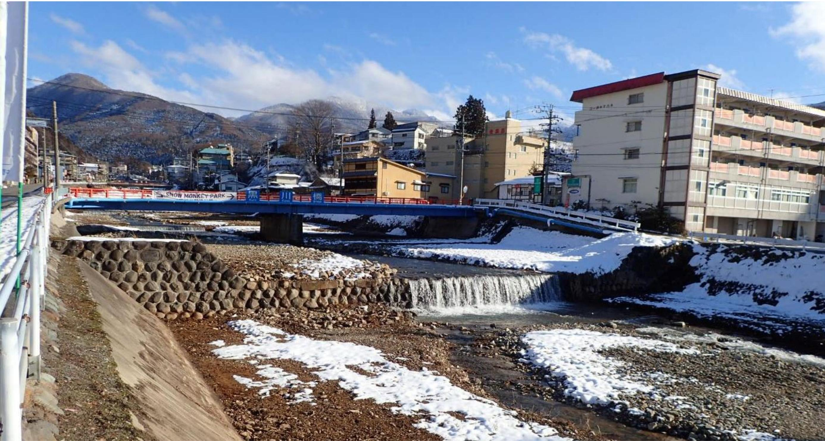
夜間瀬川に合流する横湯川に築かれた練石積堰堤です。古くから大災害を繰り返してきた横湯川に始めて砂防堰堤が施工されたのは明治39年ですが、明治42、43年の大洪水によって、施設のほとんどが流失してしまい、砂防工事は廃止されてしまいました。地元住民の陳情により、大正7年から内務省直轄工事が始められ、昭和7年から砂防事業は県へ移管されました。
