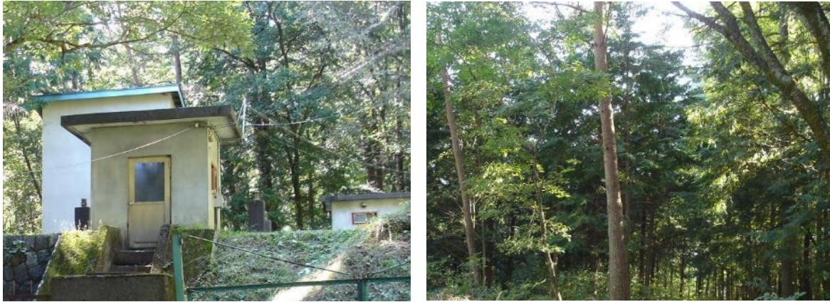
写真 I-3 水道施設（左）と水源上流の森林（右）
