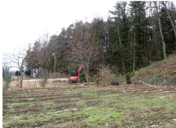
写真 I-6 獣害対策（緩衝林整備状況）
