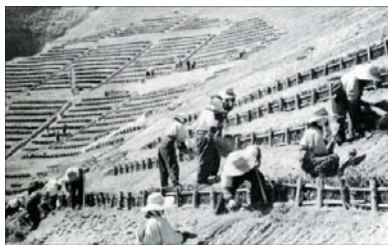
山腹緑化の施工状況(喬木村九十九谷 昭和初期)
