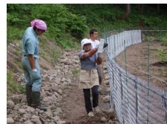
防護柵の設置を協働で実施
