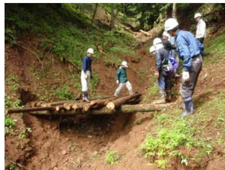
④「棚入れ」による簡易施設の設置状況
