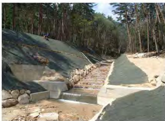
丸太木工沈床と床固工
