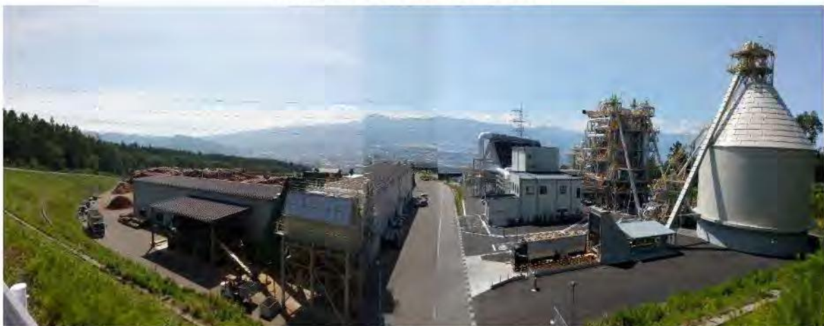
木質バイオマスの発電施設(塩尻市)
