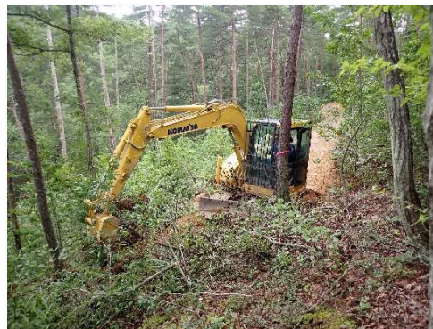
作業道の作設
