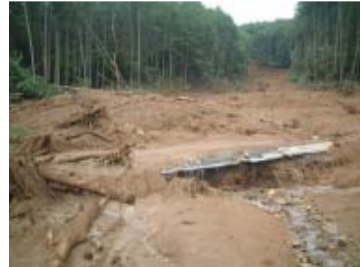
平成18年7月豪雨災害(岡谷市)
