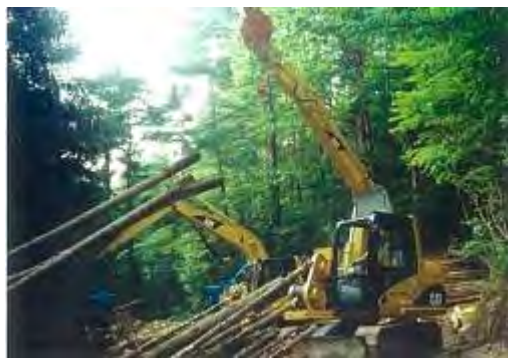
高性能林業機械による搬出間伐
