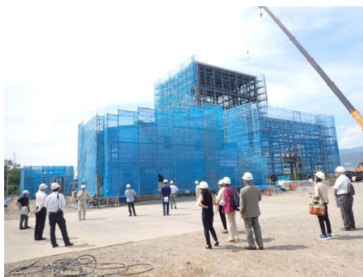
(木質バイオマス発電施設の建設状況を視察)
