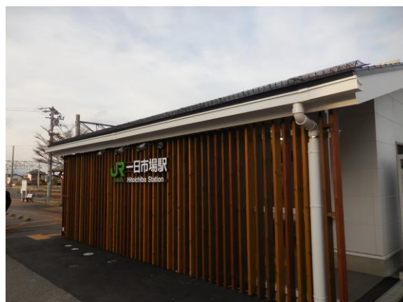
＜認証事例＞ 公共建築物 (安曇野市 JR大糸線 一日市場駅) 県産材使用量 9.92 m 3 CO 2 固定量 7.0 t-CO 2
