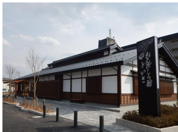
< 認証事例 > 公共建築物 (下諏訪町 おんばしら館よいさ) 県産材使用量 77.13 m 3 CO 2 固定量 47.5 t-CO 2
