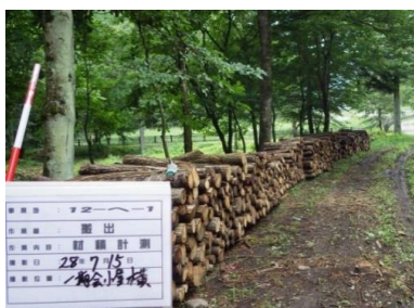
搬出材の集積状況
