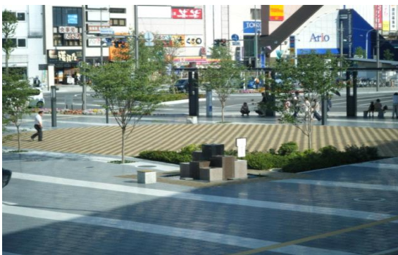
認証事例 公共土木 (松本駅お城口(東口)広場) 県産材使用量28m 3 CO 2 固定量 19.3t-CO 2
