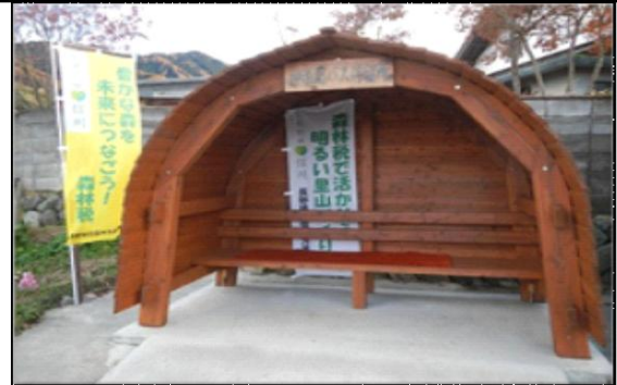
中野市：スギ間伐材バス停の設置 地域のスギ間伐材を利用し、屋根、ベンチ付のバス停を設置。併せて森林税のPRを実施
