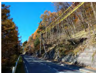
○ライフライン等保全対策 (危険木伐採)
