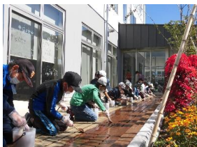
ウッドデッキ作り (茅野市)
