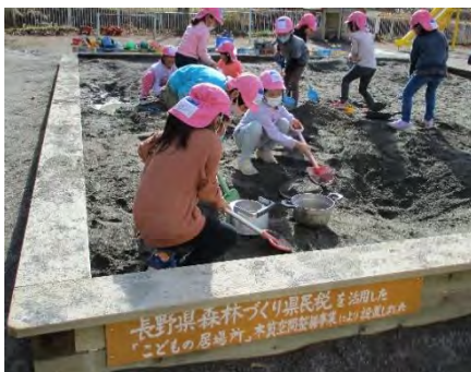
原村保育園(原村) 砂場囲いの設置
