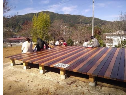
三穂君崎公園(飯田市) ウッドデッキの木造化
