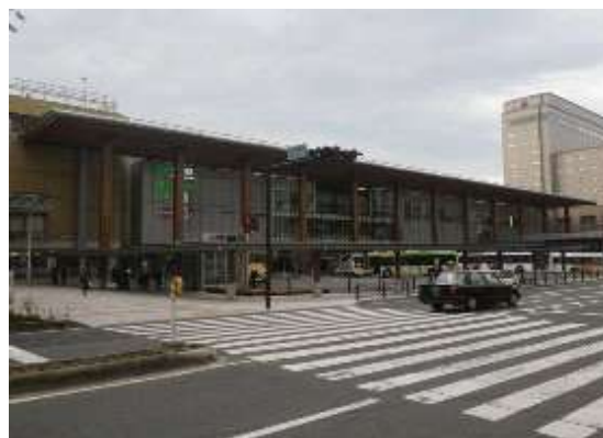
認証事例 公共建築物 (長野市 門前回廊) 県産材使用量 285.9m 3 CO 2 固定量 164.6t-CO 2
